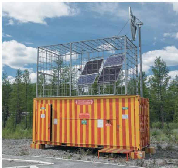
В ПЭС предусмотрена функция обратной связи с оператором МЧС и система видеонаблюдения для контроля трафика, проезжающих автомобилей. В радиусе 200 метров от ПЭС действует сотовая связь.
